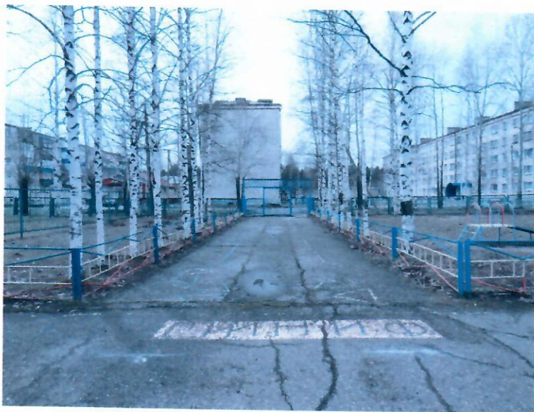
Фото 6 – Центральный вход в здание. Наличие противоскользящих полос для МГН.
