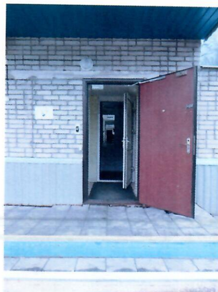
Фото 7 – Запасной вход в здание. Наличие противоскользящих полос для МГН.
