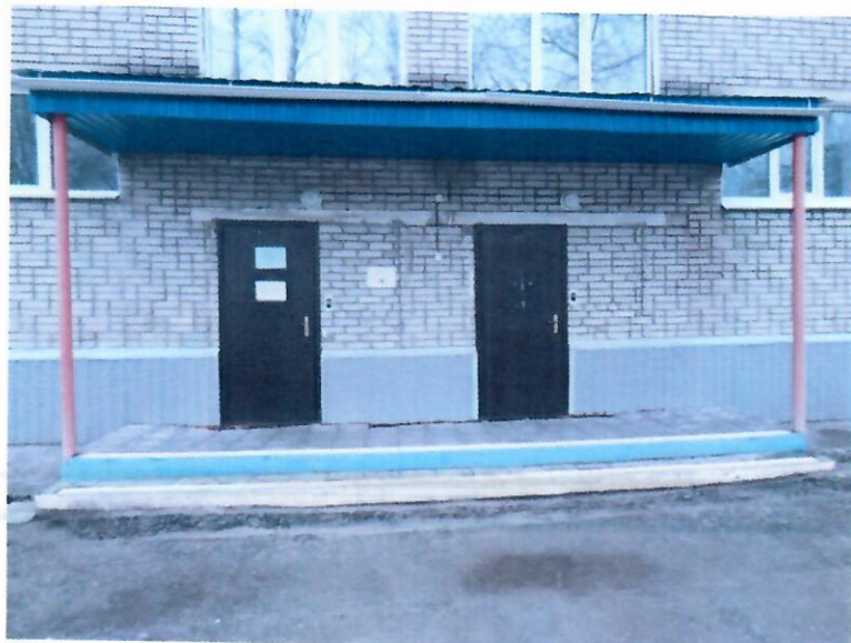
Фото 7 – Запасной вход в здание. Наличие противоскользящих полос для МГН.
